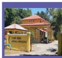
PEMBAIKAN KUARTERS KD LAYANGAN
