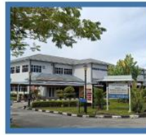
SISTEM AHU KLINIK KESIHATAN LABUAN
