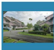
PEMBAIKAN KUARTERS HOSPITAL LABUAN
